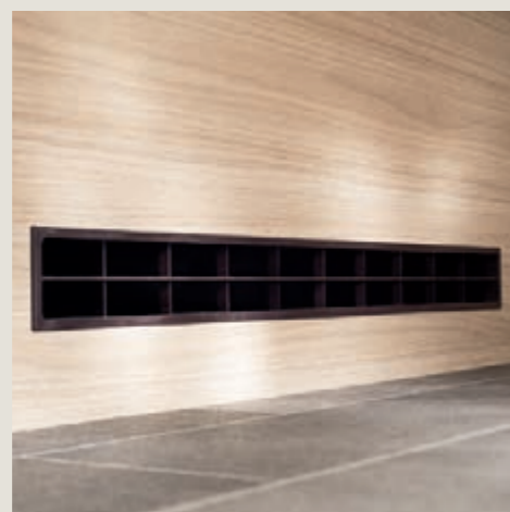
Hoog geplaatste ventilatieroosters zorgen voor een goed klimaat en voorkomen dat er vuil in de openingen terechtkomt.
